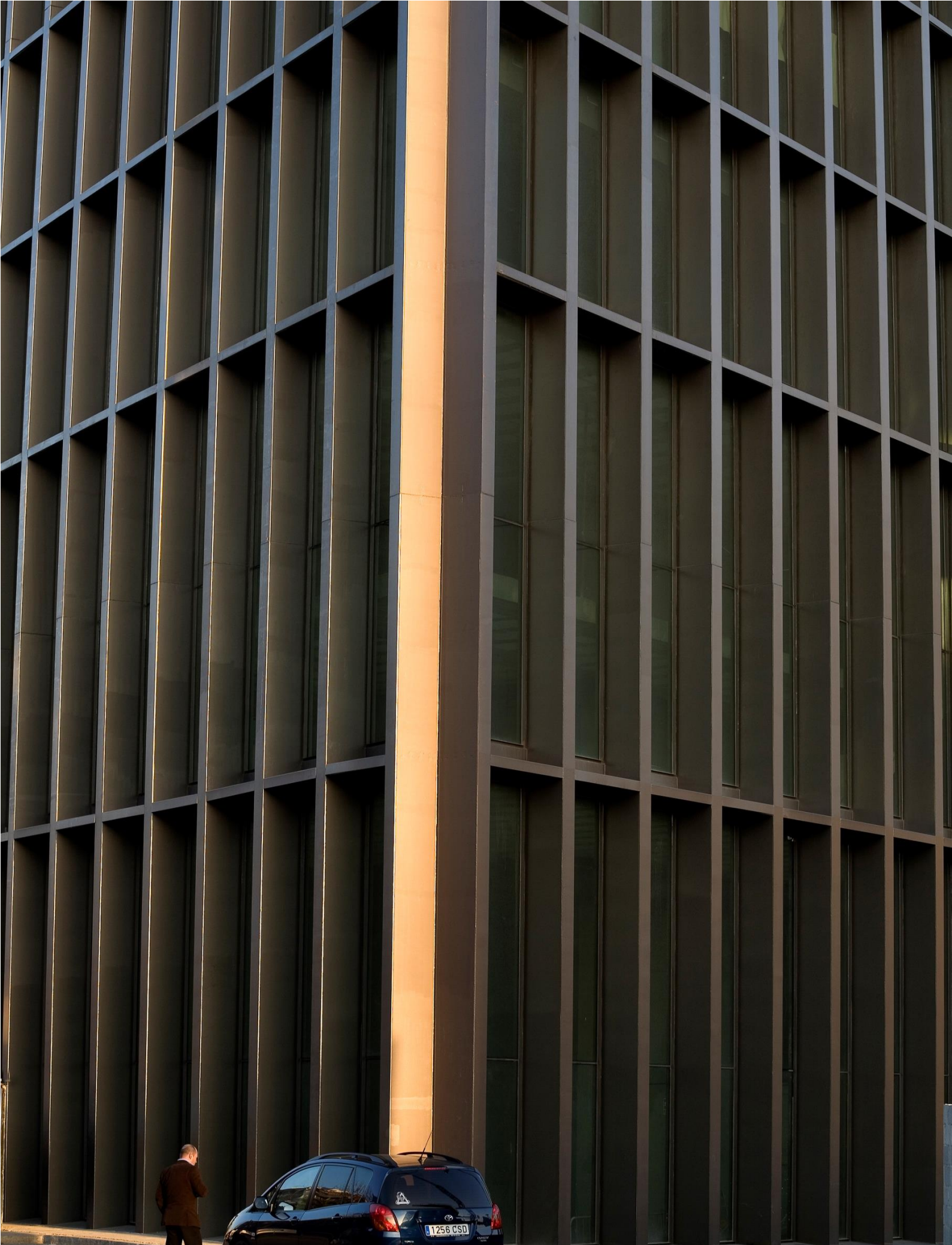
Más de 1100 ventanas Forster único con paneles de cristal de hasta 3,1 m de alto – nuevo Edificio Mediapro en el Campus Audiovisual, Barcelona, España
