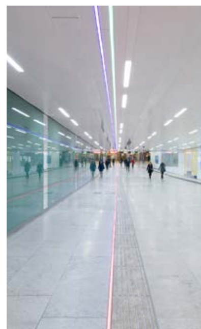
Fire resistant glazing EI30/EI60 – Karlsplatzpassage, Vienna, Austria
